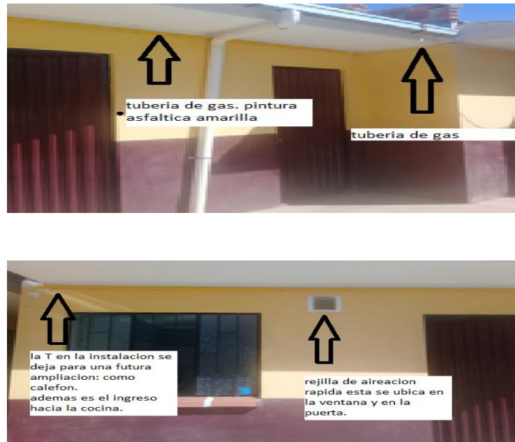
Figura 18: Instalación del gas natural al inmueble:
