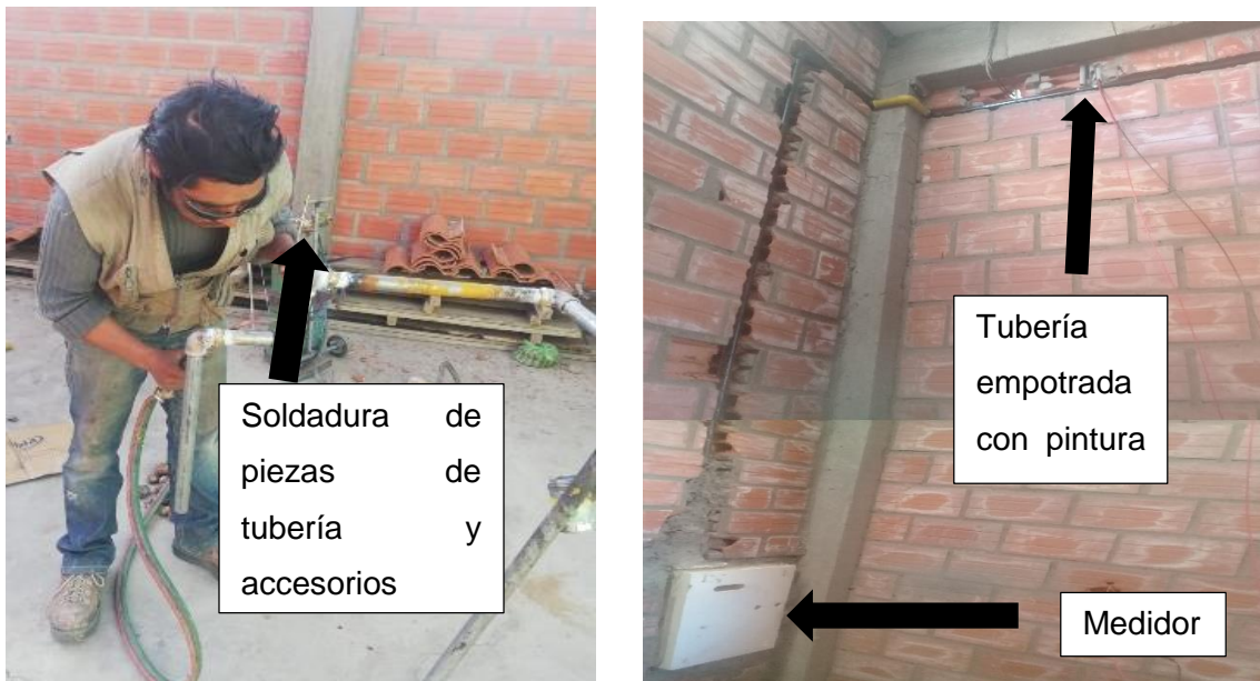
Figura 17: supervisión de obra en campo
